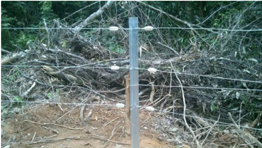
Rajah 19: Pagar Elektrik yang Digunakan
